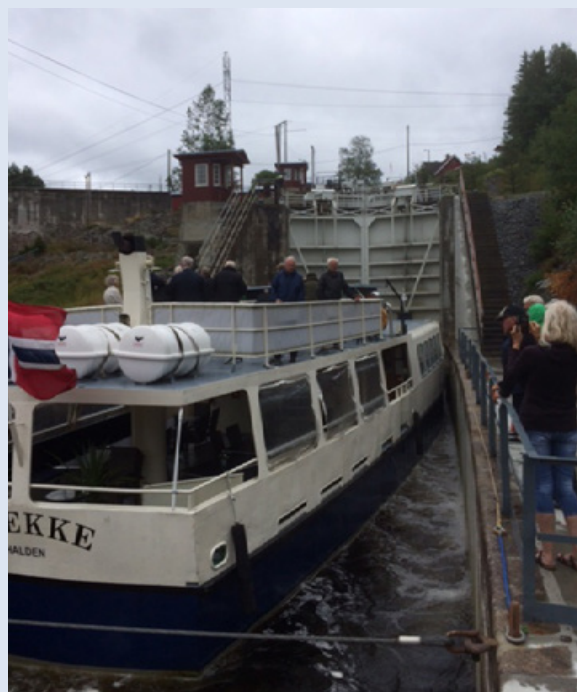
Brekke Sluse - et spændende besøg på en regnvejrsdag. Brekke sluse er nord-europas højeste 26,6 m med 4 kamre hvor bådene løftes igennem.
